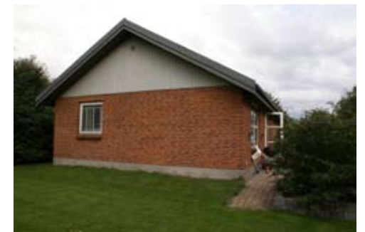
Foto A - Eksisterende forhold
